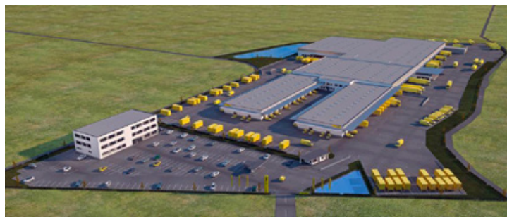
Das neue Logistikzentrum der Österreichischen Post AG. Bild: GOLDBECK RHOMBERG
