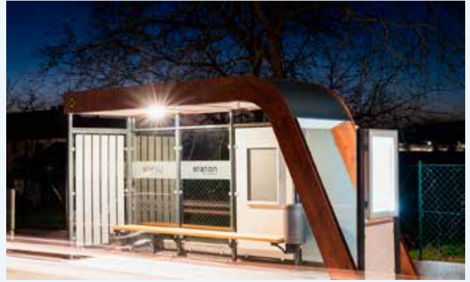
Das Buswartehaus von Fonatsch funktioniert mit Sonnenstrom, kann zum Infopoint ausgebaut werden und ist mit USB-Anschluss ausgestattet. Es fungiert als E-Bike-Ladestation, ist gut beleuchtet sowie barrierefrei und auch W-LAN ist verfügbar. Foto: Fonatsch
